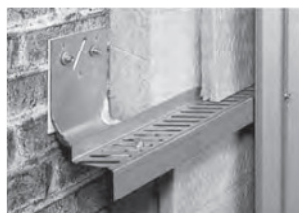
Sous-construction avec console
