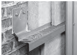
Sous-construction avec console
